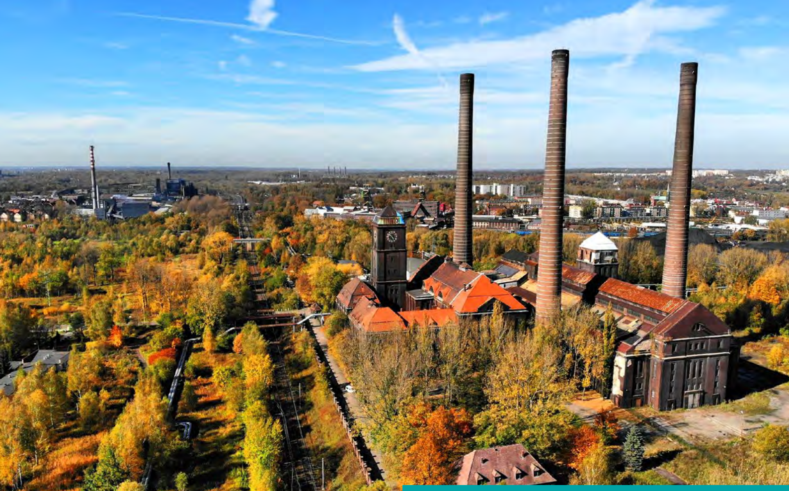
Elektrociepłownia w Szombierkach.
