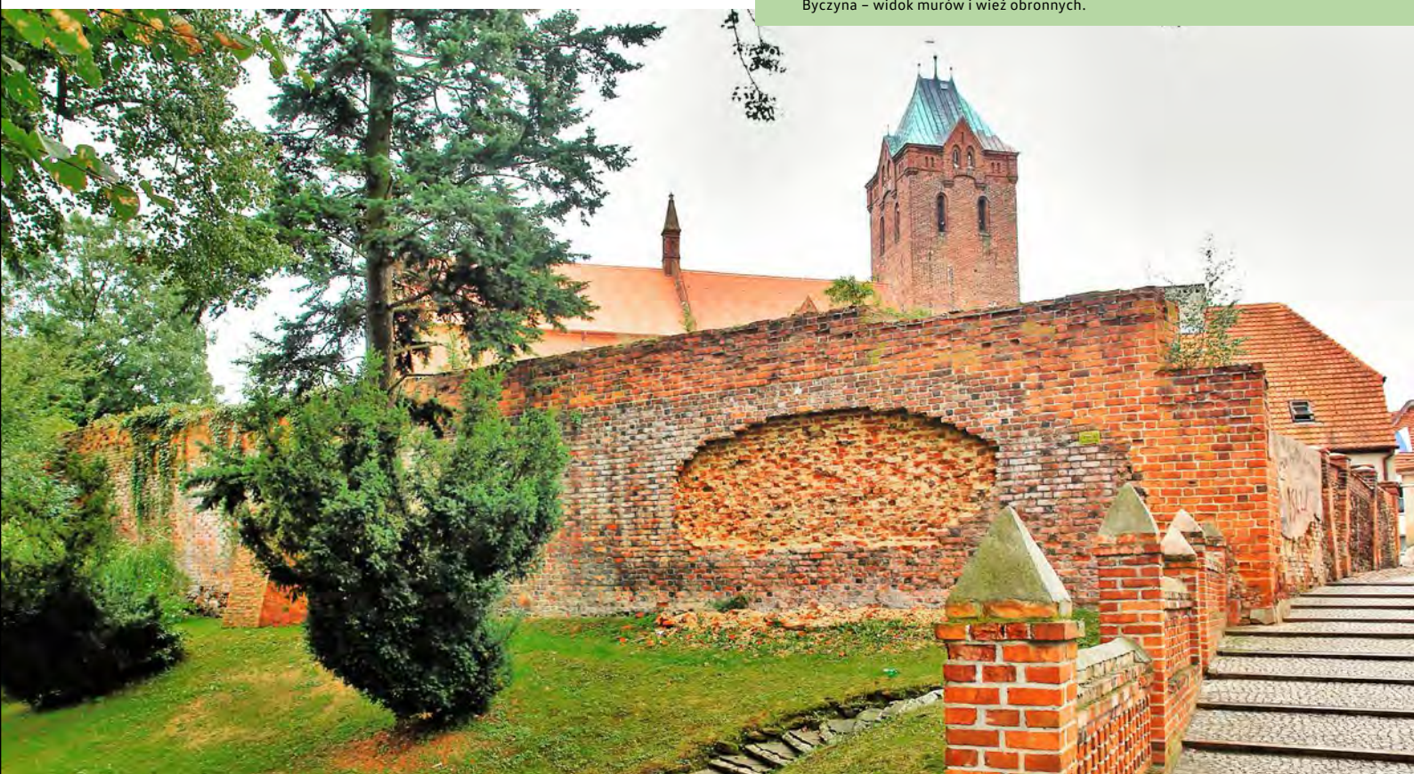
Byczyna – widok murów i wież obronnych.
