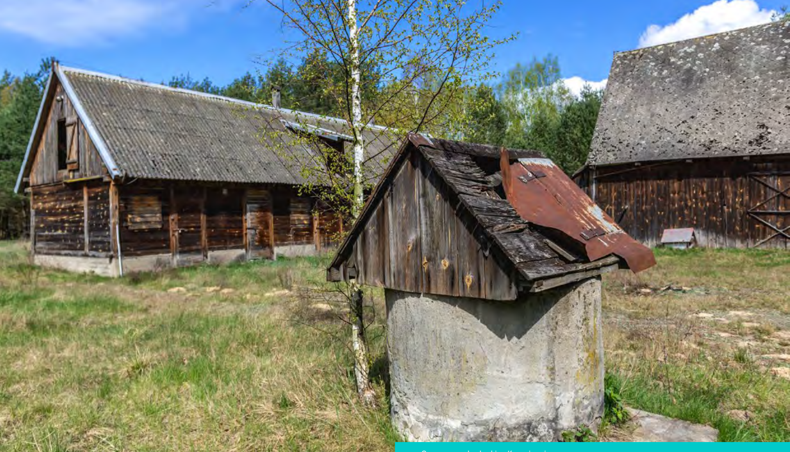
Opuszczone budynki w Kampinosie.
